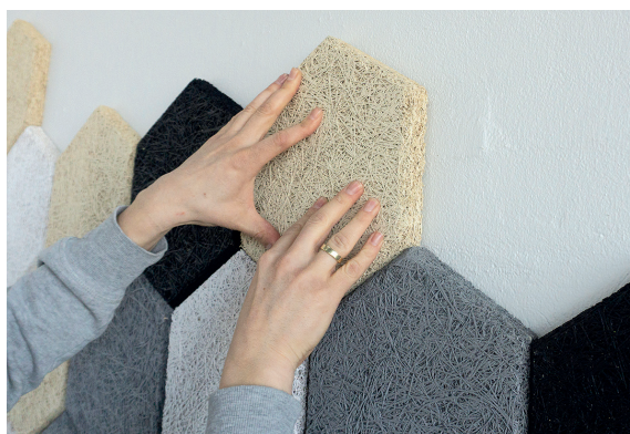
4: Sæt herefter den enkelte hexagon op i det mønster som du ønsker at skabe. Husk, at du let kan tilskære hexagonerne, så du opnår præcis det mønster du ønsker. Fortsæt processen til dit look er fuldendt.
